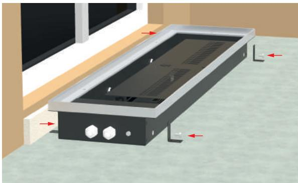
2. Установить конвектор в отопительный канал, после чего закрепить установочные ножки, с помощью дюбелей и крепёжных винтов, к основанию отопительного канала;
